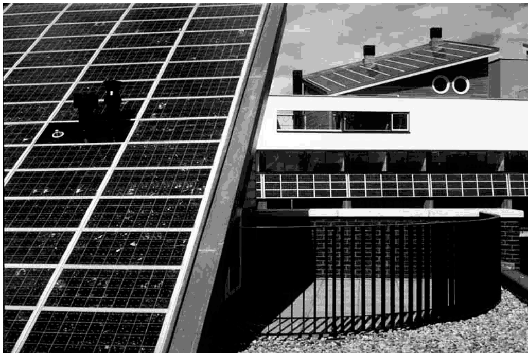
Figuur 4.16 Een grootschalig bouwproject (Nieuw Sloten) nabij Amsterdam. (©foto Ecofys-Novem, NL)
