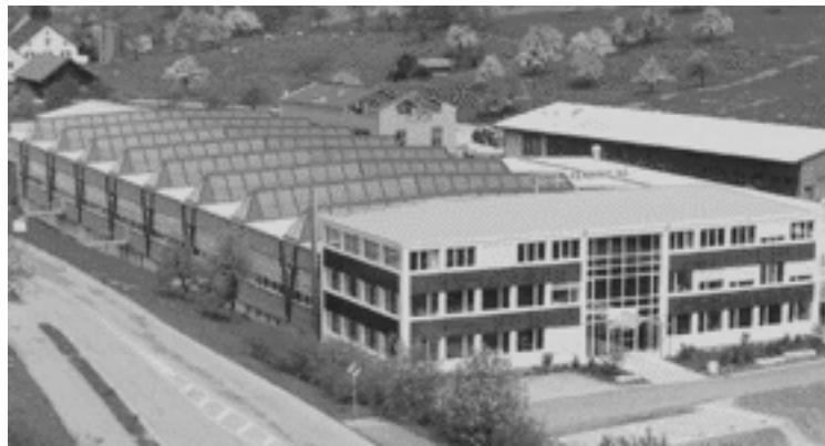
Figuur 4.19 Gevels en daken van kantoorgebouwen bieden mogelijkheden tot integratie van fotovoltaïsche systemen. Het dagelijkse verloop van productie van zonne-elektriciteit en het verbruik ervan vallen hier trouwens veel beter samen dan in een residentiële toepassing.
