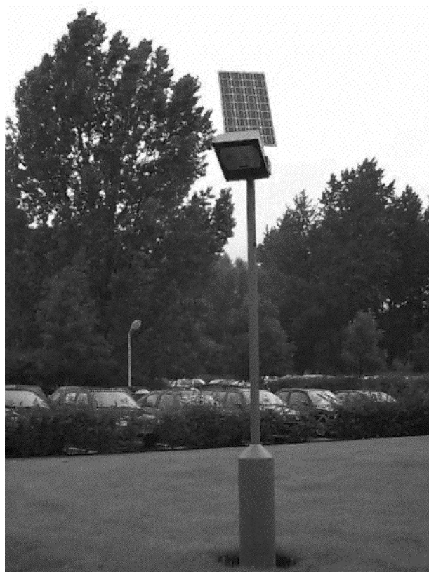
Figuur 4.5 Park(eer)verlichting met een autonome fotovoltaïsche verlichtingspaal.
