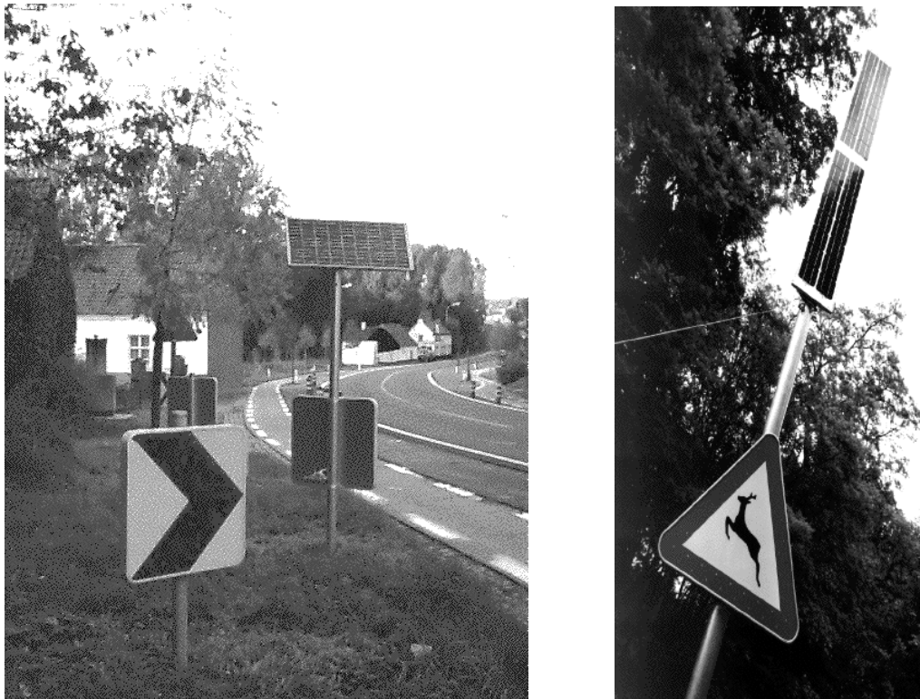
Figuur 4.6 Bepaalde vormen van verkeerssignalisatie vragen weinig energie of zijn nodig op plaatsen die zich ver van een netaansluiting bevinden. (© foto IMEC)
