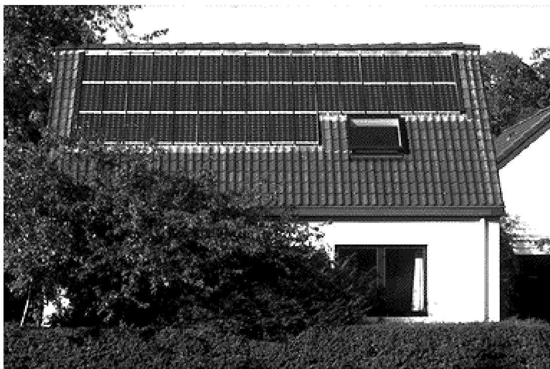
Figuur 6.6 Foto van het eerste netgekoppelde dakgeïntegreerde fotovoltaiische systeem in België, gelegen op de Antwerpse Steenweg in Oostmalle. Deze installatie kadert in een IWT-VLIET-project (partners IMEC, WTCB, LABORELEC, Soltech en Batech) met co-financiering van Electrabel.
